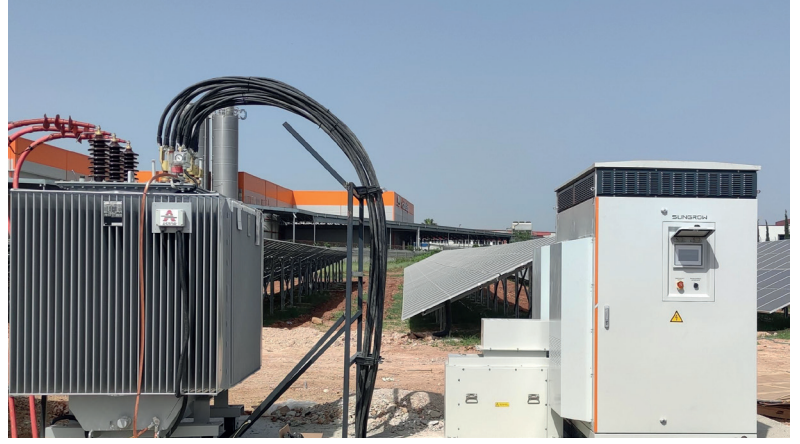
SG3125HV-30, Maks. PV giriş akımı 3997 Amper'e kadar. Maks. Verimlilik: %99 / Avrupa Verimliliği: %98,7
